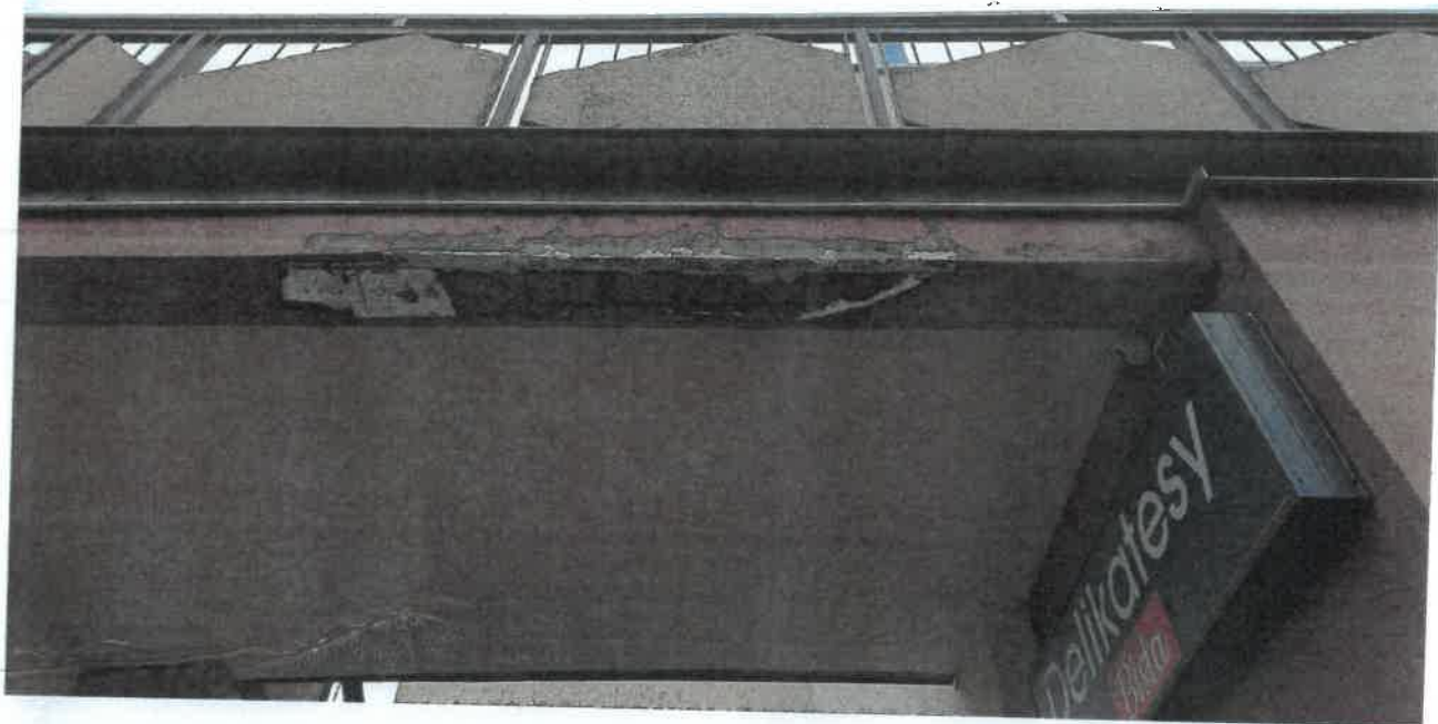
ZDJ. NR 7. ANTRESOLA – UBYTKI TYNKU Z WIDOCZNYM ODSŁONIĘTYM ZBROJENIEM PŁYTY.
